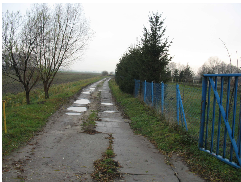
Droga dojazdowa od strony ul. Polnej (źródło: archiwum własne)
