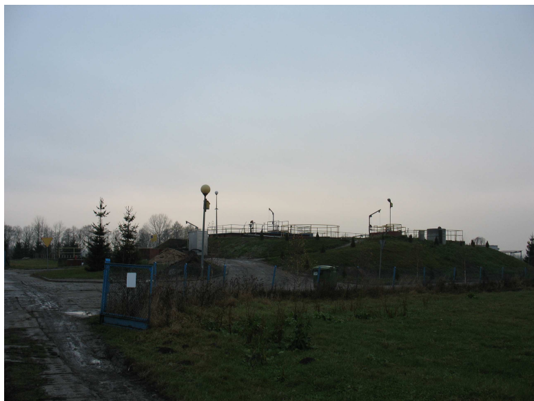
Oczyszczalnia ścieków – widok ogólny (źródło: archiwum własne)
