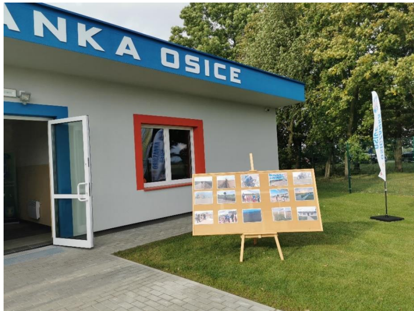
Rysunek 3- odbiór nowego budynku szatni w Osicach
