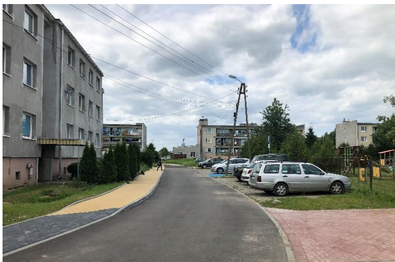
Rysunek 4 - nowy, wyremontowany odcinek ul. Sportowej w Suchym Dębnie
