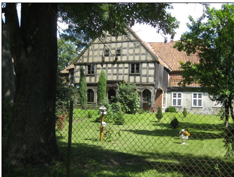
Fot. 4: Jeden z zabytkowych domów podcieniowych w Steblewie
