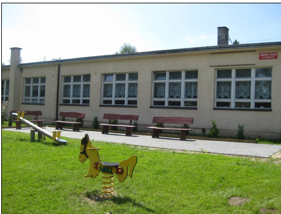
Fot. 5: Świetlica wiejska w Steblewie
